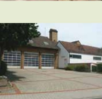
Ansicht Schulstraße 19 - 25 von Stiftstraße
